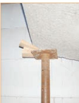
Treppenlauf muss bis zum Verguss der Mauerwerksöffnung und dessen ausreichender Erhärtung unterstützt werden.
