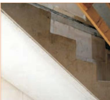
Die hohe Qualität erspart Putzarbeiten. Fliesenbeläge können direkt aufgeklebt werden.
