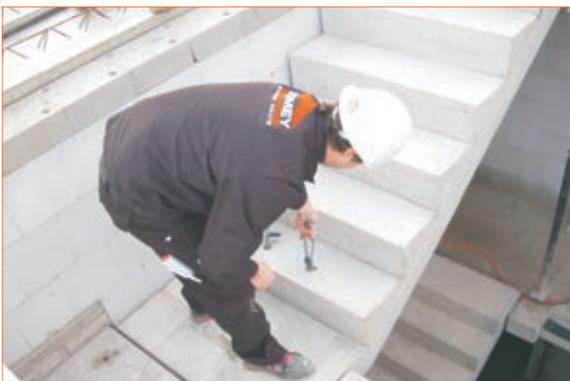
Treppe ist nach Montage und Entfernung der Seilschlaufen sofort begehbar.
