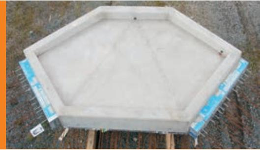
Balkonplatten erhalten zur kontrollierten Entwässerung eine umlaufende Aufkantung und ein Gefälle zur Rinne, die das Wasser in den Ablauf leitet
