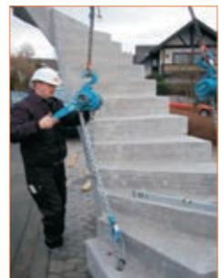
Treppenlauf wird dann "in die Waage" gebracht und ausgerichtet.
