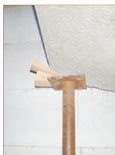
Treppenlauf muss bis zum Verguss der Mauerwerksöffnung und dessen ausreichender Erhärtung unterstützt werden.
