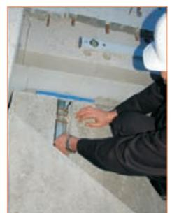
Das Rechteckhohlprofil wird in die Mauerwerksöffnung hineingeschoben und anschließend vergossen. **14 | 15**
