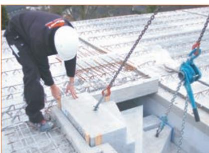
Fugen werden mittels Keile eingestellt.
