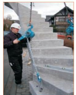
Treppenlauf wird "in die Waage" gebracht.
