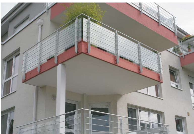
Fertigteil-Eck-Balkonplatten Bauvorhaben in Idstein, Bad Homburger Str.
