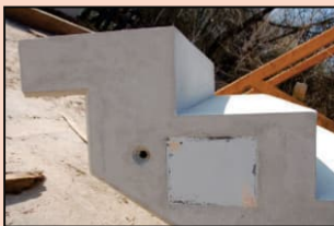
Ankerplatten für Geländerbefestigung
