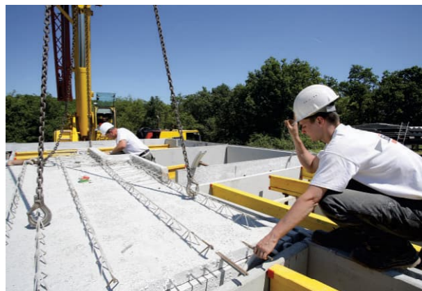
Verlegung von ROMEY-ELEMENTDECKEN
