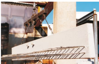
Rückseite mit Anschlussbewehrung
