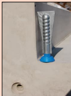
DW-15-Hülsen für die Befestigung von provisorischen Baustellengeländer mit DW-15-Gewindestäben
